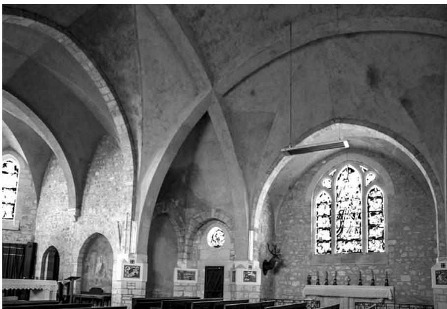
L'emploi, pour voûter la nef, de nervures en ciment armé qui évitent les colonnes et supports intermédiaires et supprimant les bas-côtés, permet aux fidèles de voir l'autel et de suivre les gestes rituels de l'officiant. L'abside à trois pans et le chœur sont également voûtés d'arêtes encadrant trois vitraux.
